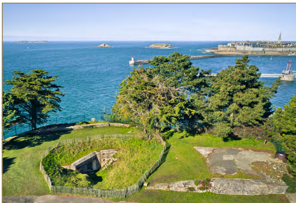
Poste directeur de tir de la cité d'Alet © Fondation du patrimoine_MyPhotoAgency-J. Sevrette
